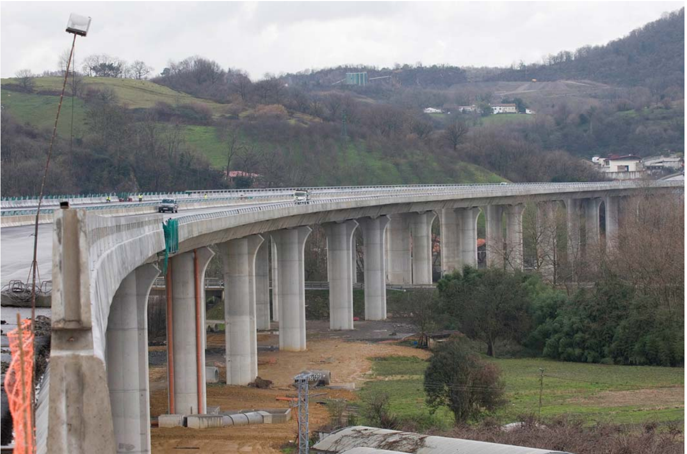
Vista panorámica del Viaducto del Urumea, el más largo de Euskadi (1 kilómetro de longitud)
